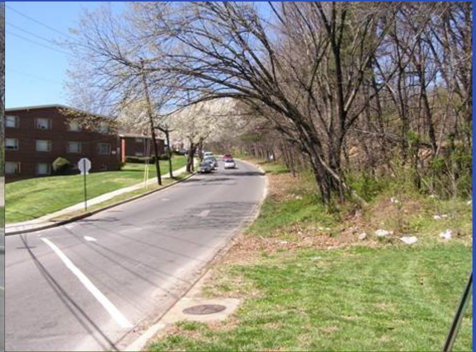
Fort Totten Drive (A6)
